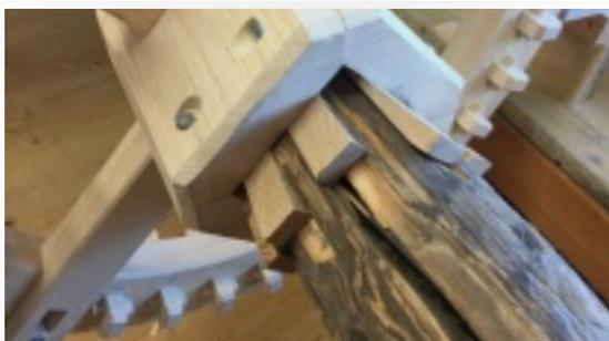
Die eingeschlagenen Keile halten das Rad in der richtigen Position. Jeder der 16 Keile wird mit einer Schraube gesichert und die Kanten der Keile dann noch angeschrägt.
