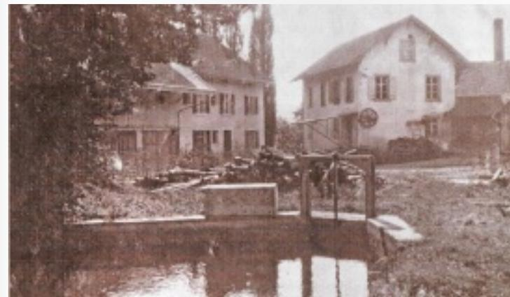
Ende des Mühlenkanals mit Spindel zur Regulierung des Wasserflusses auf das Wasserrad bzw. in die Turbine. Aufnahme 1914.
