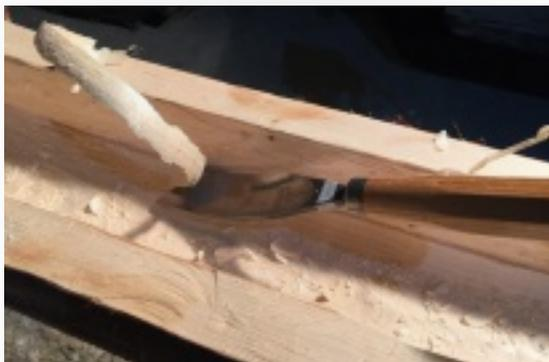
Mit einem löffelförmigen Stemmeisen und Holzhammer werden Unebenheiten nachgearbeitet. Diese Arbeiten plane ich für die Wintertage, im Innern des Wagenschopfes vor Nässe und Kälte geschützt.
