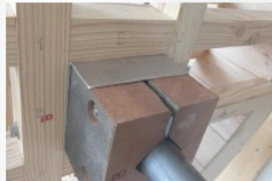
Um einen exakten Rundlauf des Rades (axial und radial) zu gewährleisten, wurde Platz für Ausgleichsplatten von 1.5 mm Dicke gelassen.
